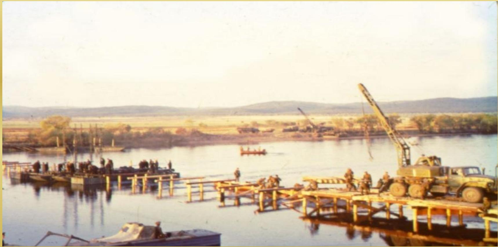
Для устройства стационарных переправ, переправ через преграды, где невозможно применение плавающей техники, используются установки строительства мостов УСМ, позволяющие строить деревянный **60-т.** мост на свайных опорах со скоростью до 60 метров в час.
