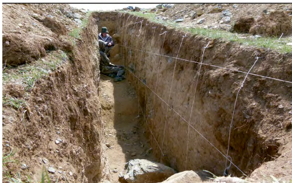
Траншейные исследования поверхностных разрывов древних землетрясений на южном склоне Курайского хребта
