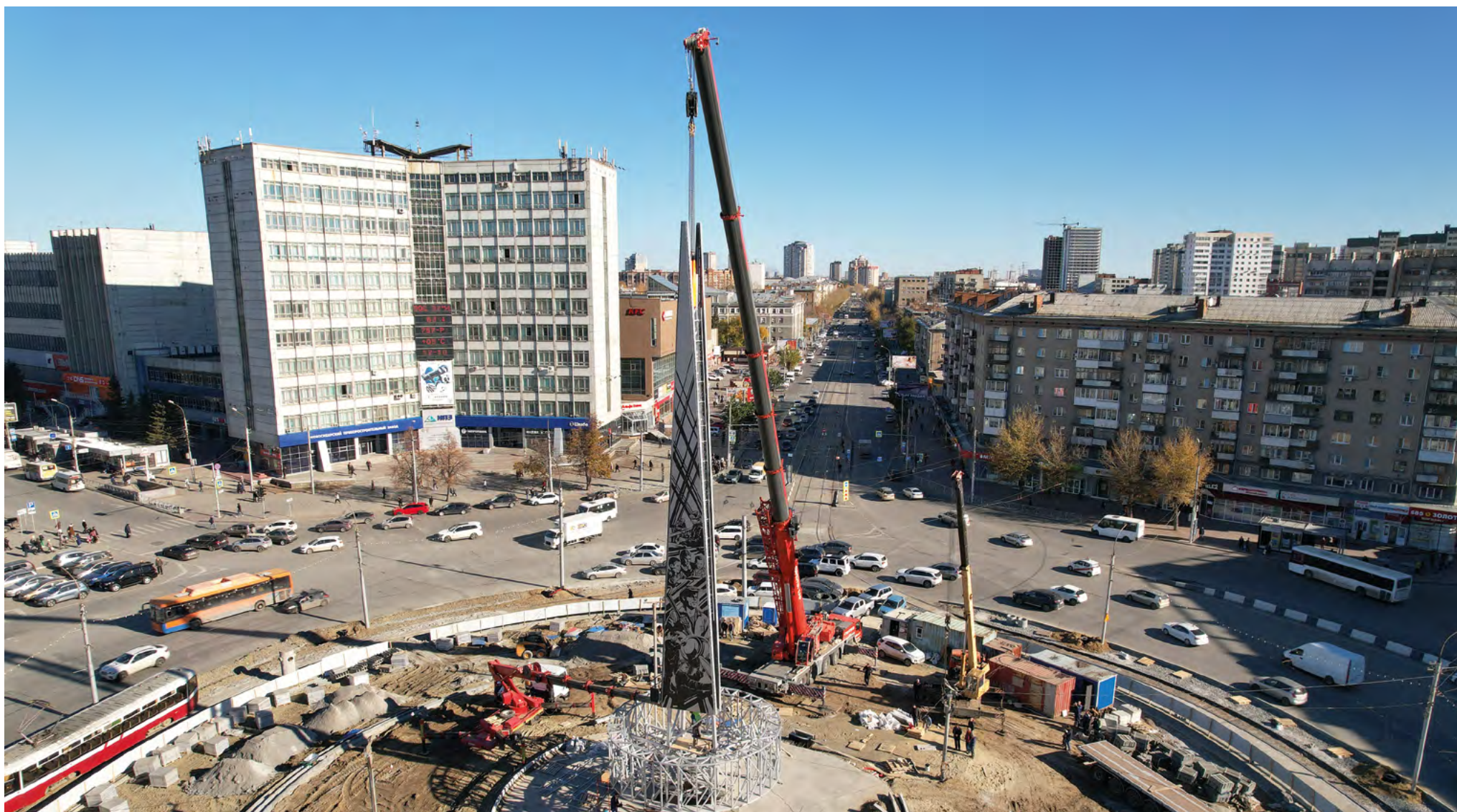
Монтаж стелы «Город трудовой доблести». Фото пресс-центра мэрии Новосибирска
